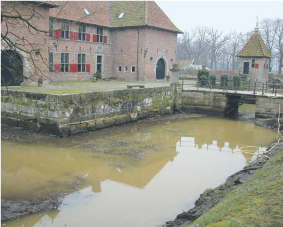
6 Lage waterstand in gracht Huis te Breckelenkamp zorgt ervoor dat de fundering bloot komt te liggen. Foto Stichting Huis te Breckelenkamp
